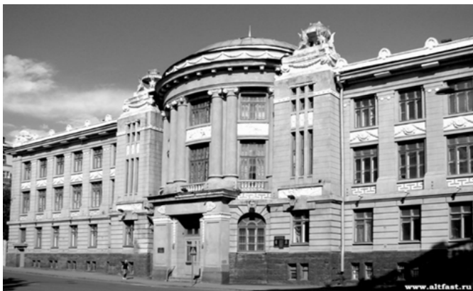
Фото 2 / Photo 2. Сучасний вигляд головного корпусу Інституту, побудованого у 1911–1913 рр. / Modern view of the main building of the Institute, built in 1911–1913.
